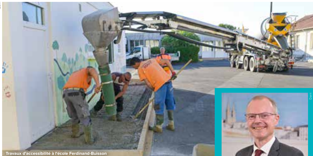
Travaux d'accessibilité à l'école Ferdinand-Buisson
