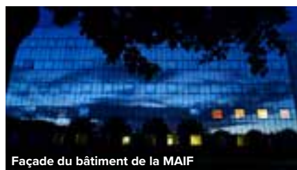
Façade du bâtiment de la MAIF
